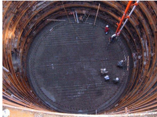
Photo 2. Sump floor concrete pour
